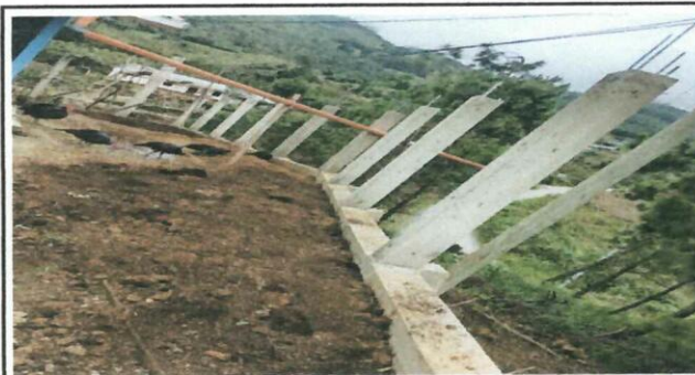
Foto 5: Foto del muro finalizado.
