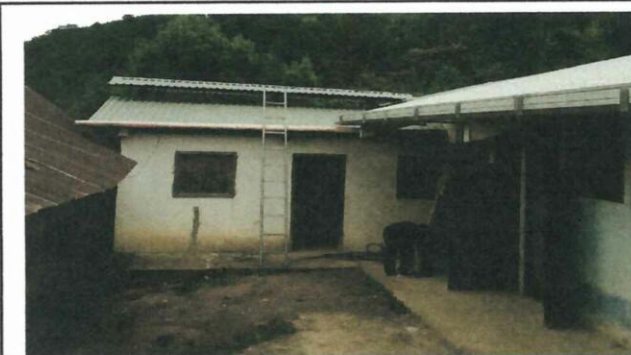
Foto 3: Foto del techo de la cocina finalizado.
