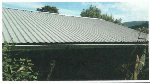
Foto 2: Fotografía del techo cambiado.
